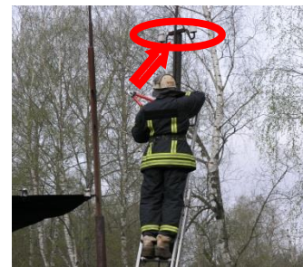
74 pav. Elektros laidų kirpimas
