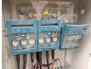
72 pav. Elektros kirtiklis
